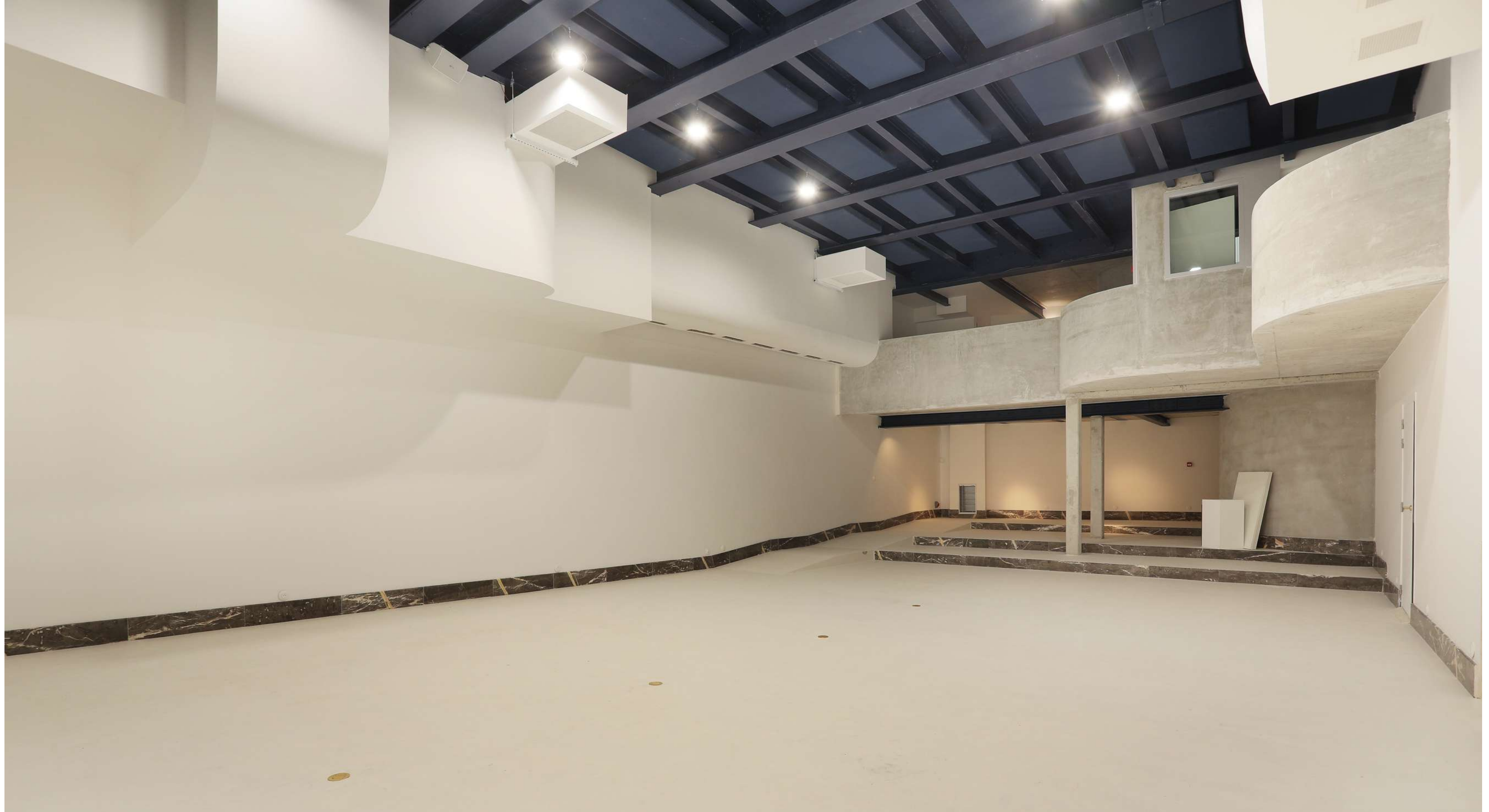
Pavillon Rive Gauche- MR Agency
